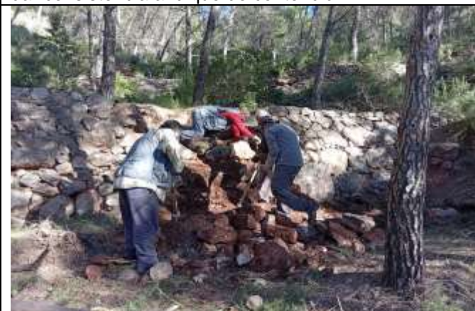
Limpieza y selección de piedras para luego su recolocación, en el muro superior.
