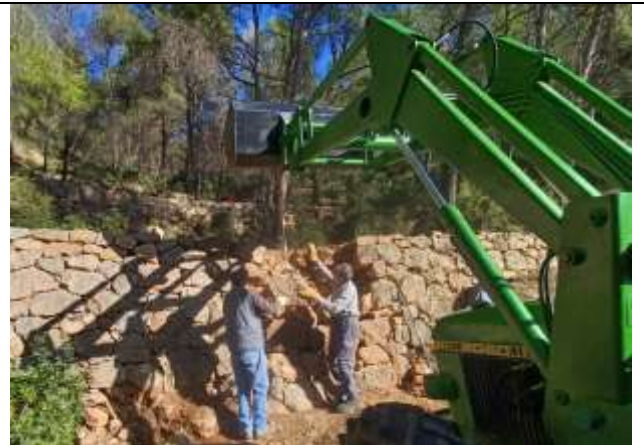
Los voluntarios colocan los mampuestos con la cara plana en línea de fachada del muro (foto de Sergio M.)
