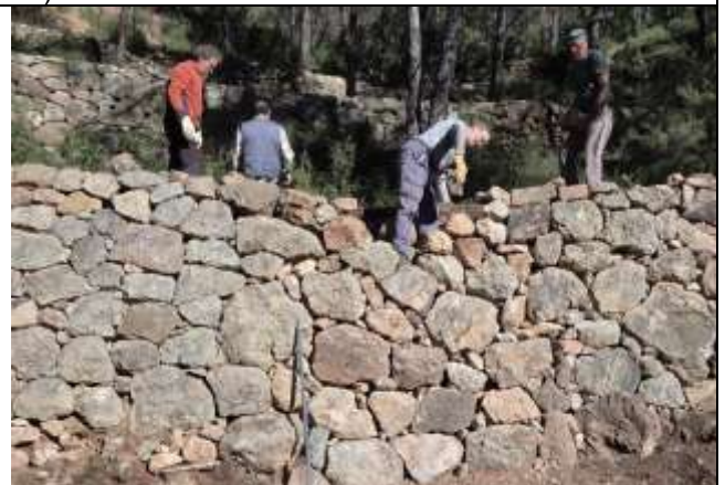
Por último se cierra la corona del muro y se coloca una línea de defensa de la zona aplanada para evitar que el agua vuelva forzar esta parte del muro.
