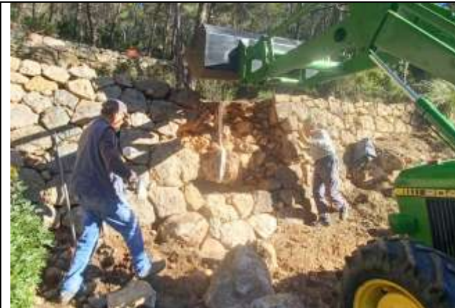
Preparación de las piedras para ser elevadas con el tractor, colgadas de una cincha, y orientadas por los voluntarios para ser depositadas (foto de Sergio M.)
