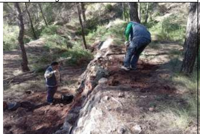
Trabajos de terminación de la reconstrucción de los muros, tras la colocación de las piedras.
