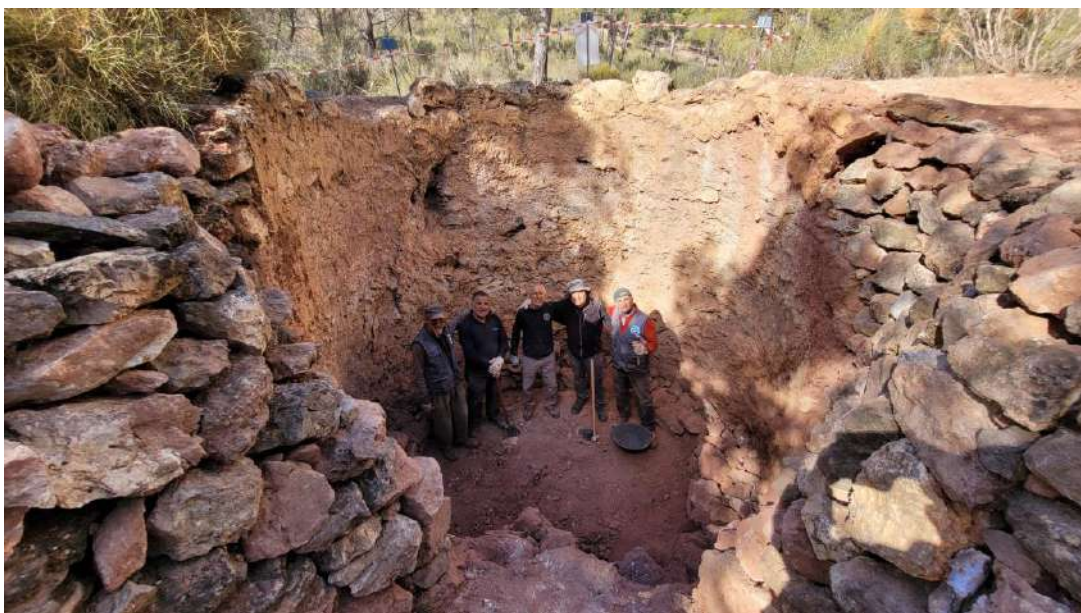
Grupo de Voluntarios X Espuña, en el interior del horno calero en la fase final de su reconstrucción.
