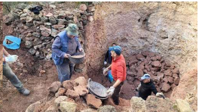
Reconstrucción de los muros de la boca del horno, en piedra seca.
