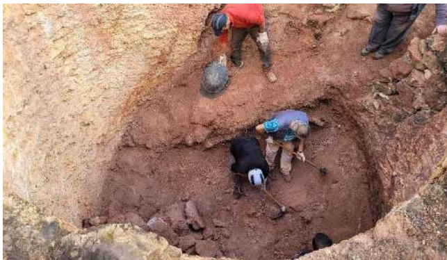
Primera fase de limpieza interior del horno calero.
